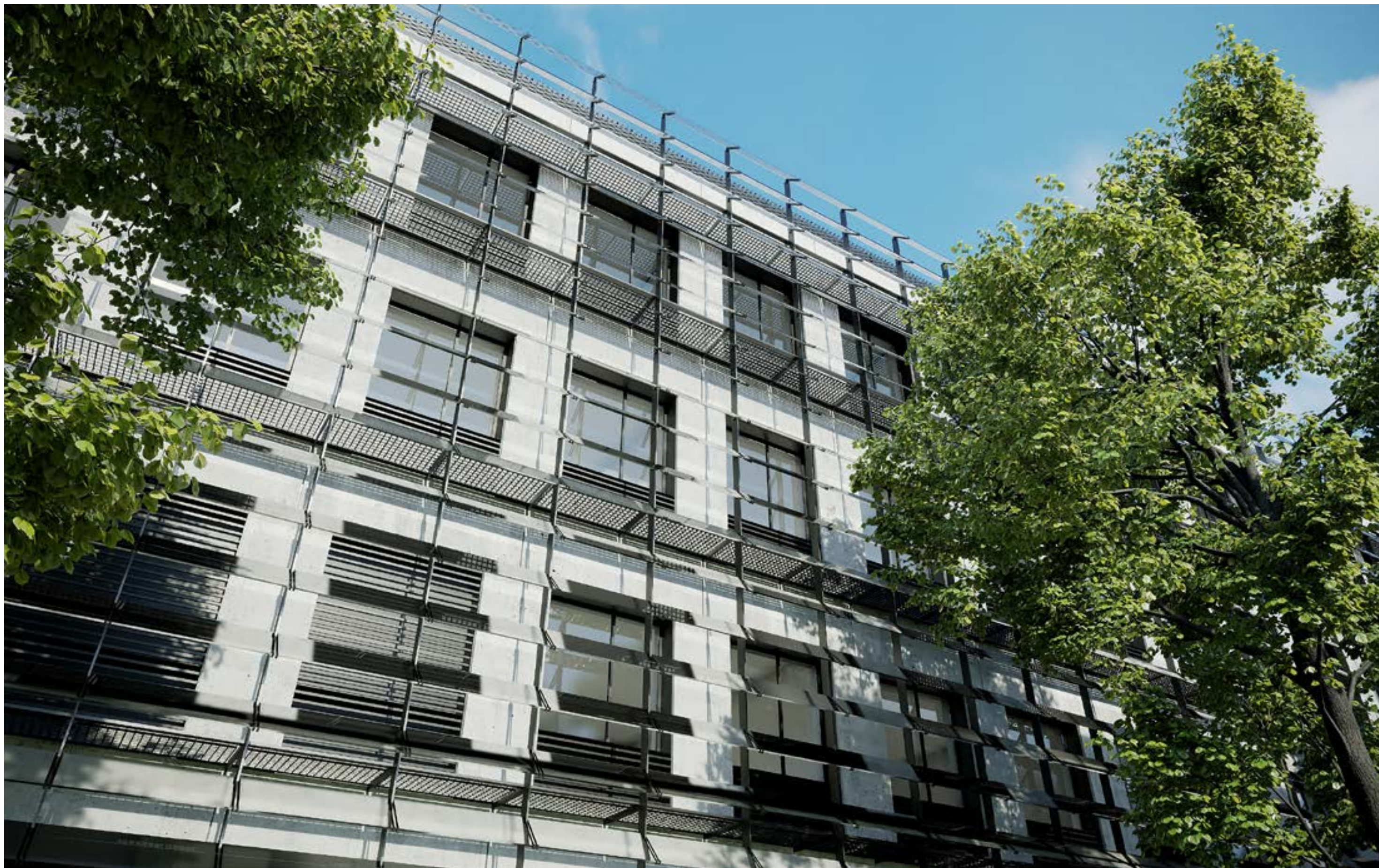
Bližší pohled na stínící systém fasády laboratorního bloku
